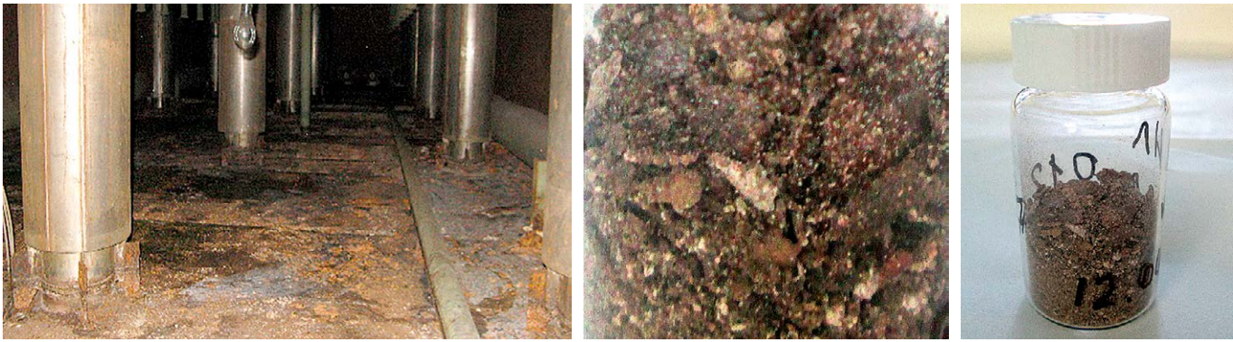
Рис. 4. ДВ, відібрані в приміщенні 012/7 об'єкта «Укриття»
